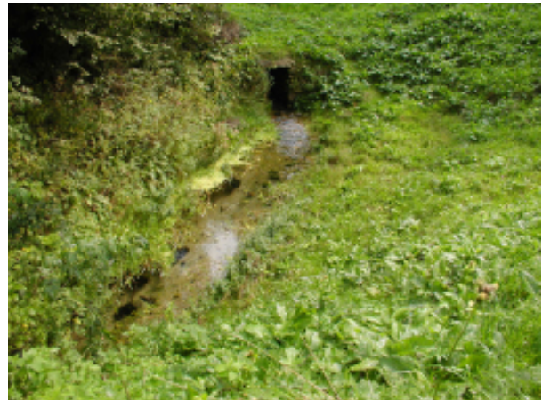
Abbildung 6: Stollenportal und Austritt der Brunnaderquelle
